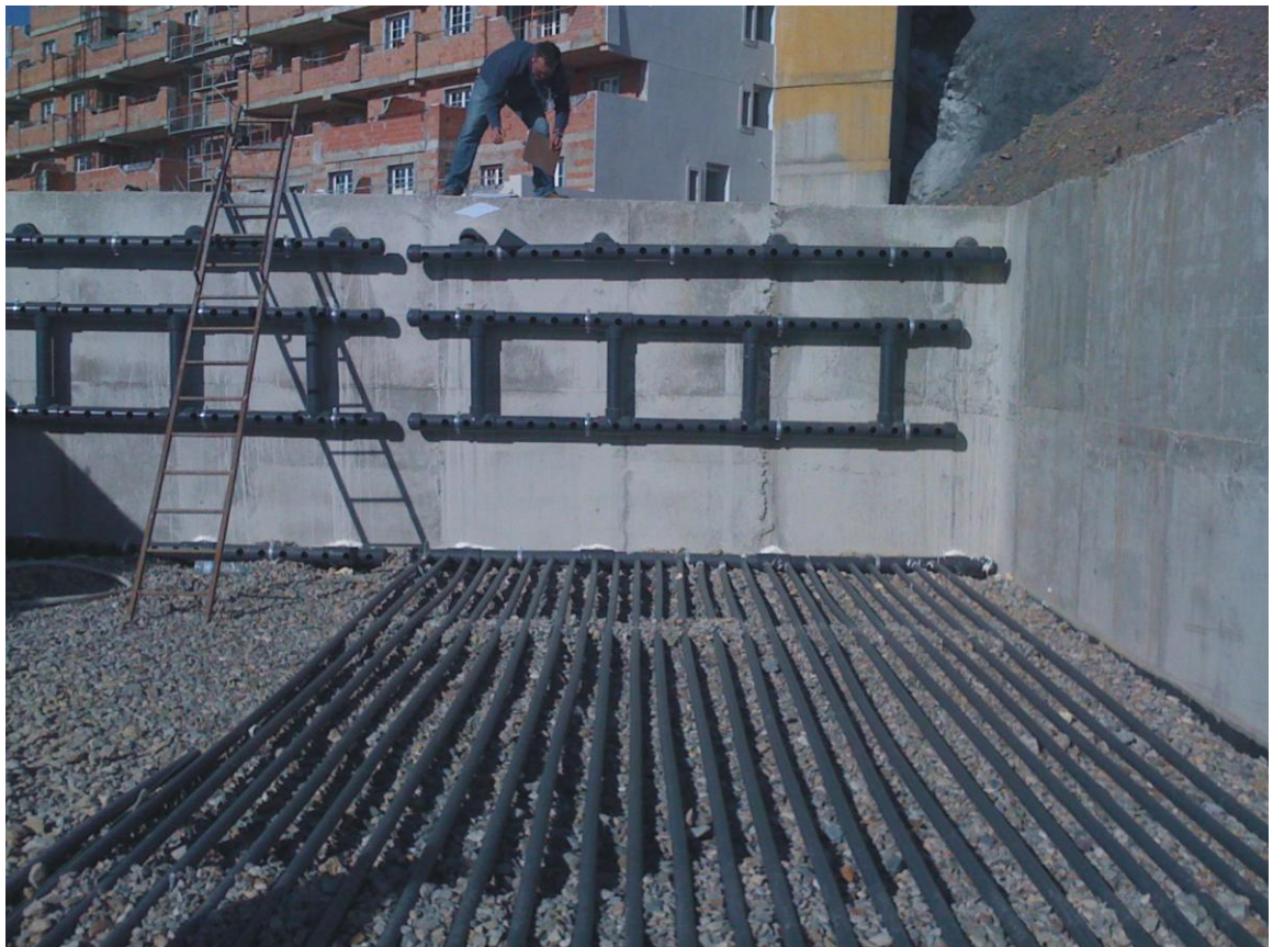
Estructura interior de una depuradora con sistema vertical de aireación
