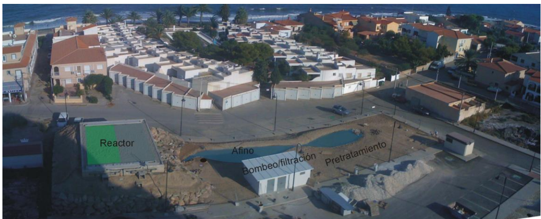
Depuradora simbiótica en una sólo fase de tratamiento que incorpora el Sistema Vertical
